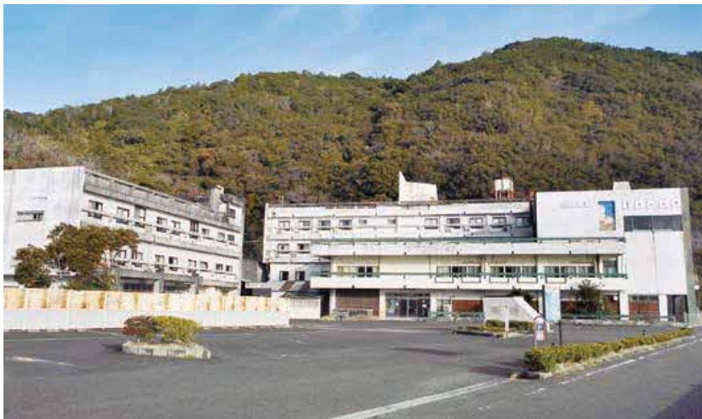
解体されるうみがめ荘
