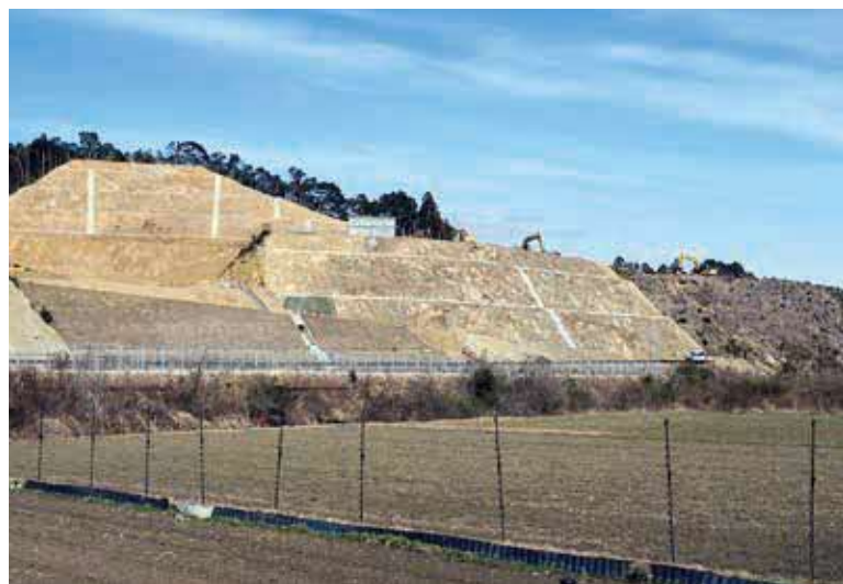
工事中の日和佐地区高台防災公園
