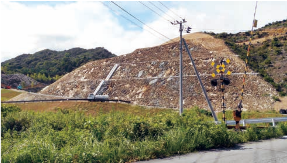
奥淵踏切付近から見た防災公園予定地
