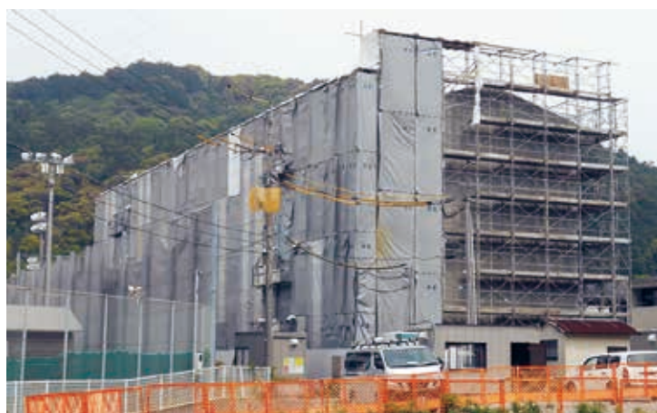
改修工事中の大久保団地
