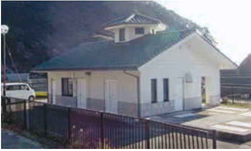
伊座利漁業集落排水処理施設
