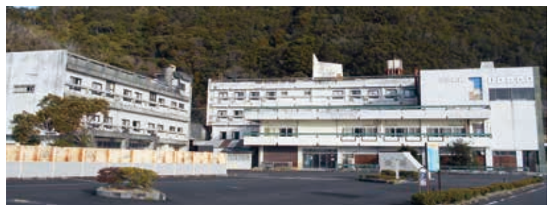
解体予定のうみがめ荘
