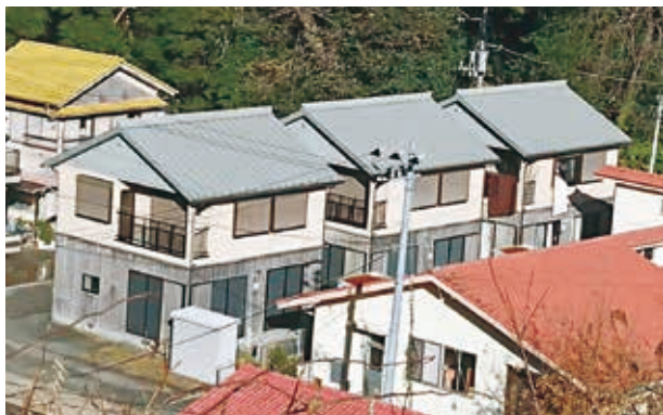
木岐若者住宅（3戸のうち2戸空室）
