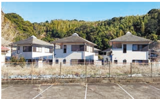
西の地若者住宅（8戸のうち4戸空室）
