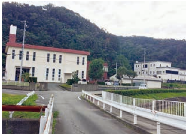
クリーンセンターと浄化センター（右）
