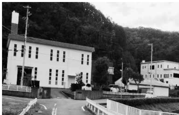
衛生処理組合が管理する、し尿処理施設
