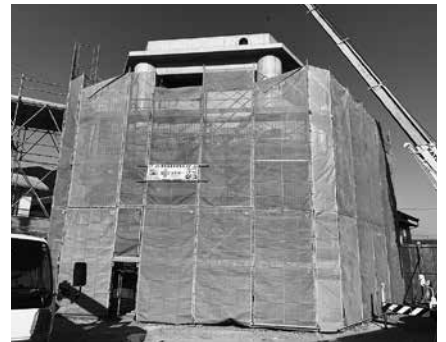
完成近い戒町地区津波避難タワー
