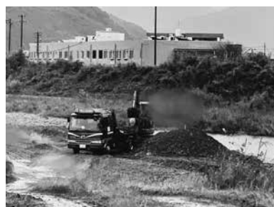
永田橋下流での土砂搬出
