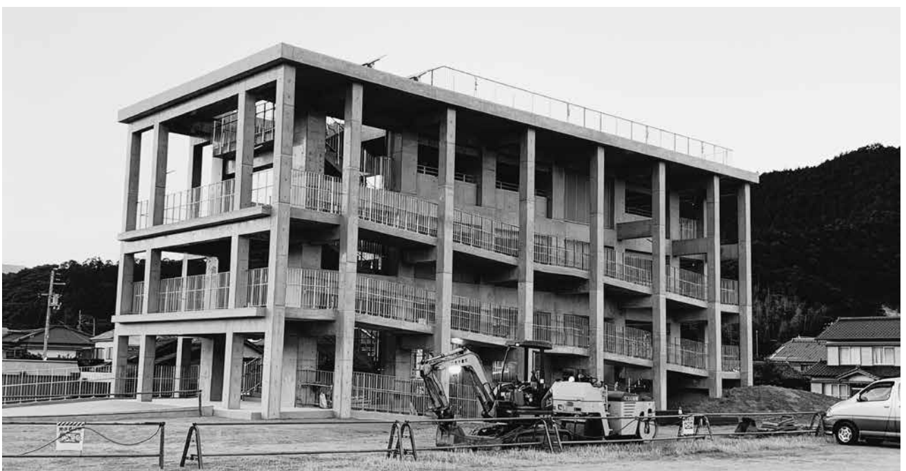
完成近い日和佐浦地区津波避難タワー（町民グラウンド）
