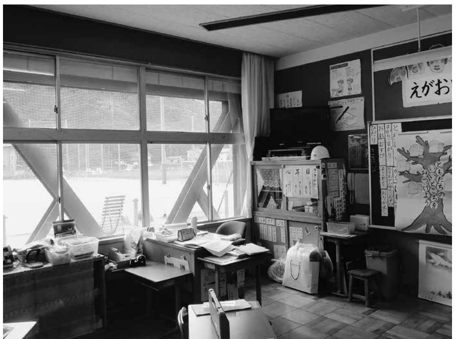
ガラス飛散防止が施された教室
