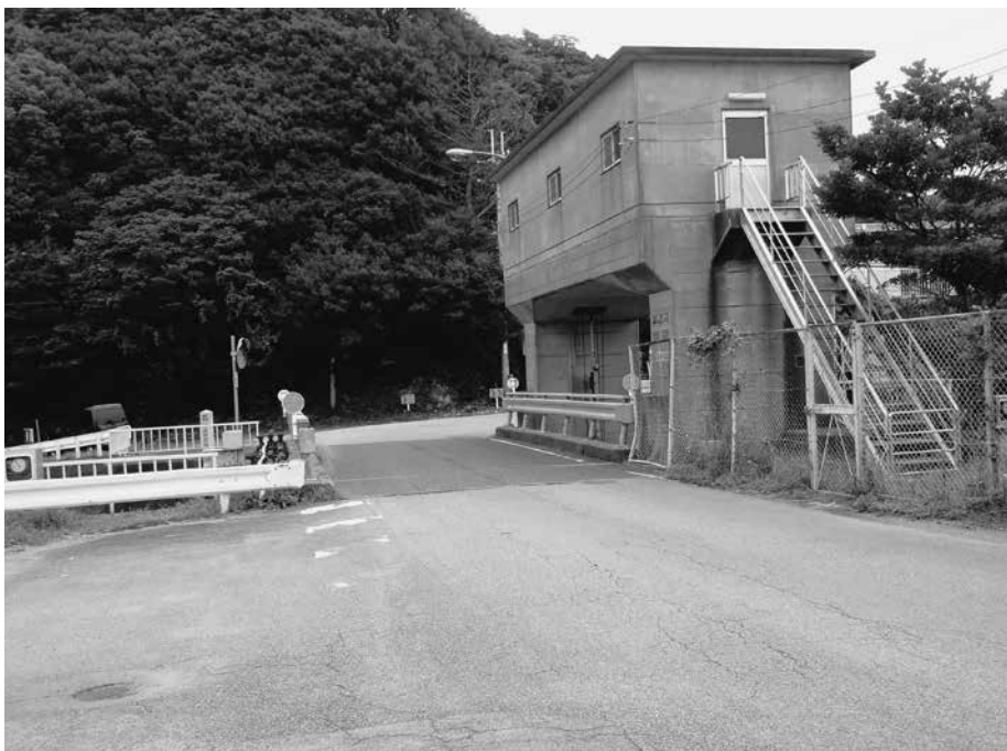
県道改良工事予定地（田井ノ浜付近）
