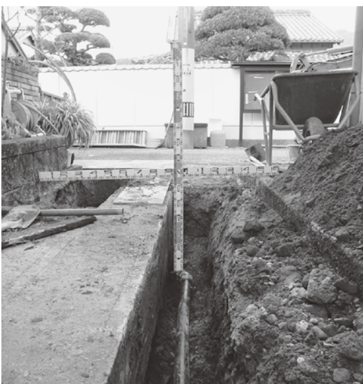
石綿管取り替え工事
