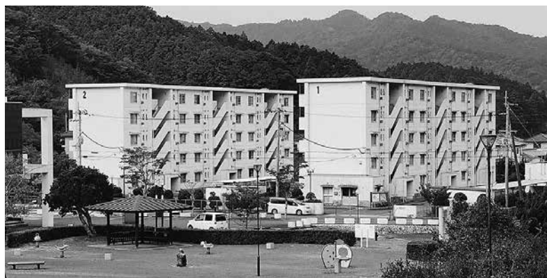
町営櫛ヶ谷住宅
