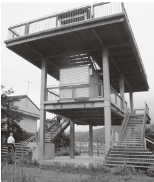
大方地区の避難タワー
