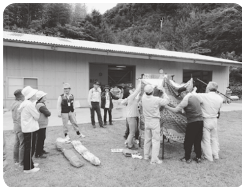
仮設トイレの設置
