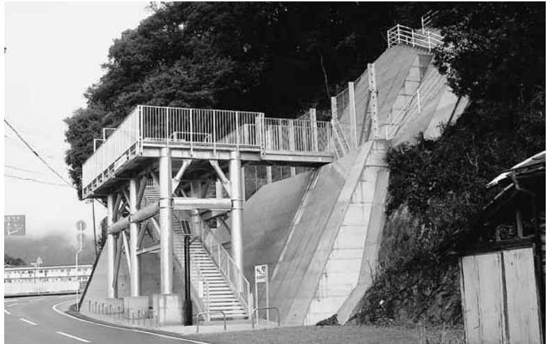
避難階段（奥河内）
