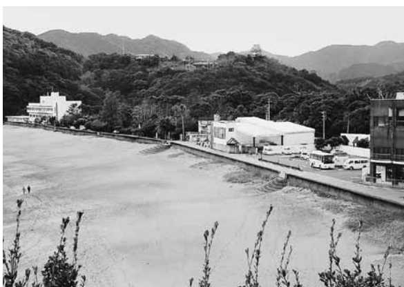
大浜海岸の防潮堤
