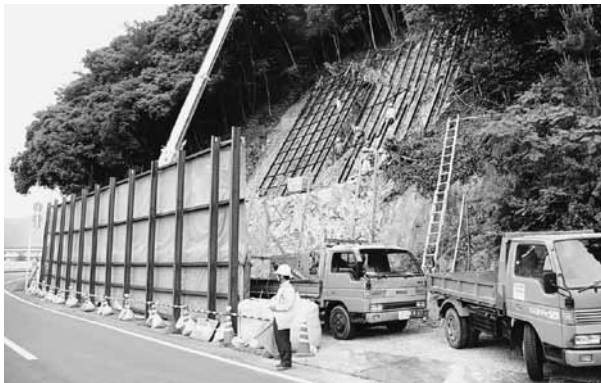
避難階段施設整備 (井ノ上)
