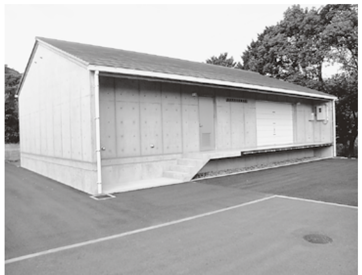
災害備蓄倉庫（日和佐高校跡地横）
