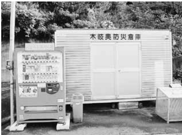
木岐奥防災倉庫
