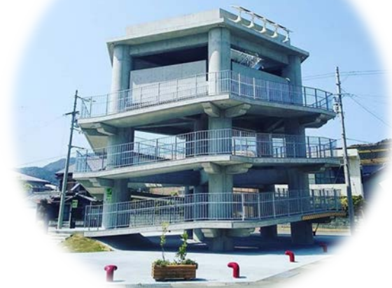
津波避難タワー
