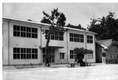
昭和42年 校舎改築
