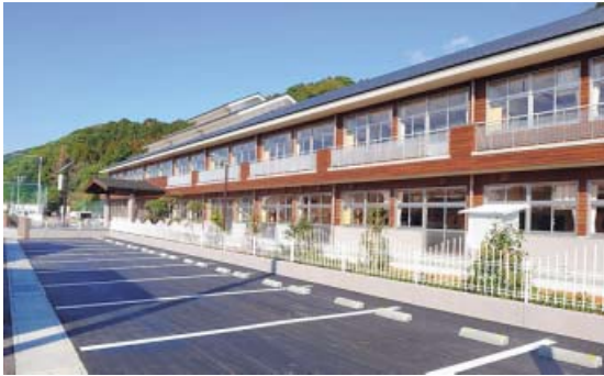
日和佐小学校新校舎 完成間近!
